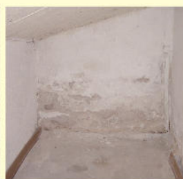
Feuchtigkeitssanierung mit Verputzarbeiten
